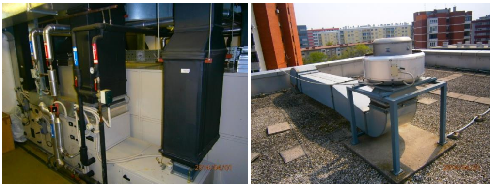
Figura 4-6 Shembuj të paisjeve të trajtimit të ajrit dhe ventilatorit të shkarkimit të ajrit në çati
