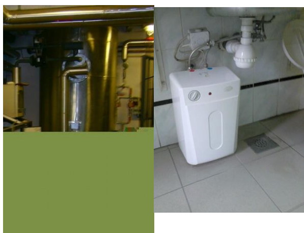
Figura 4 7 Shembuj të paisjeve për UNS në sistemin qendror të ngrohjes dhe në atë individual
